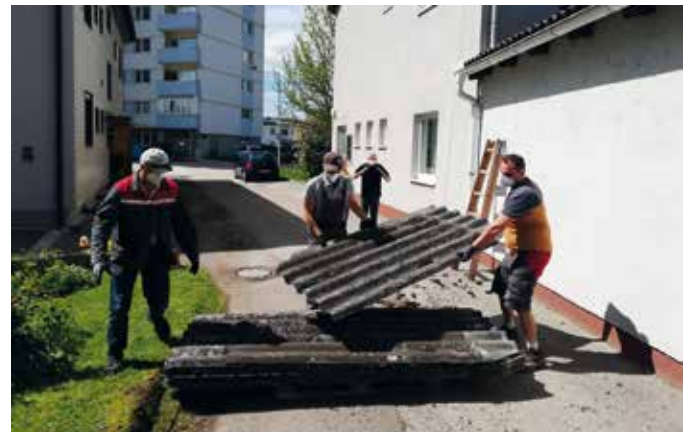
Abriss des Unterstandes des ehemaligen Bauhofes
